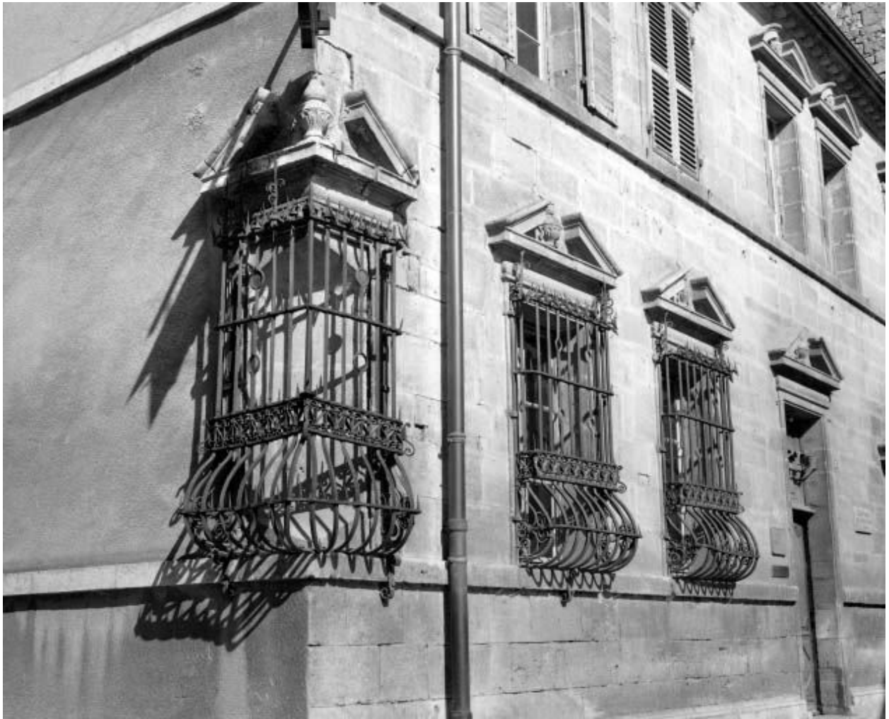
Façade antérieure, détail : baies du rez-de-chaussée, vue de trois quarts gauche.
