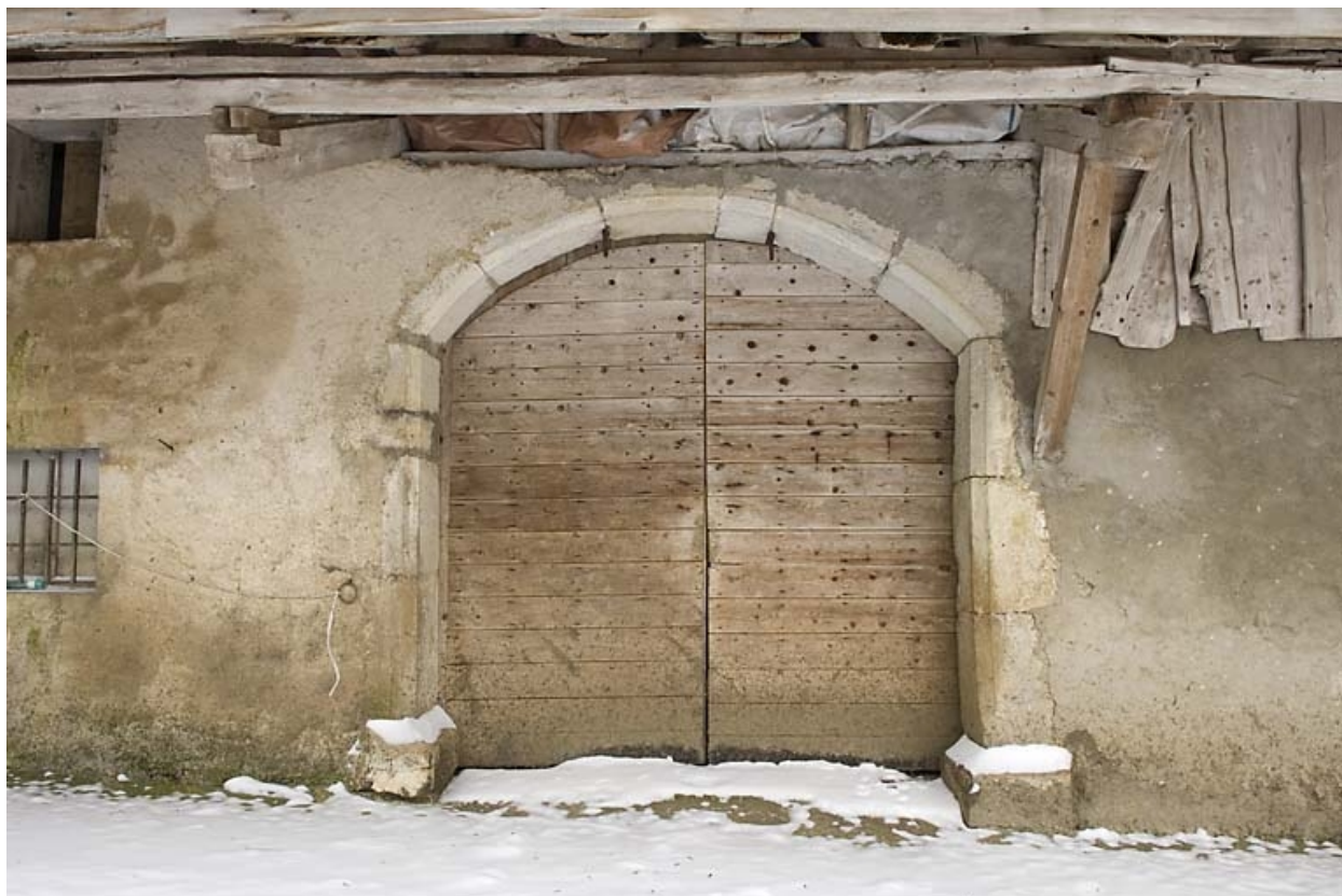
Façade postérieure : porte de grange.
