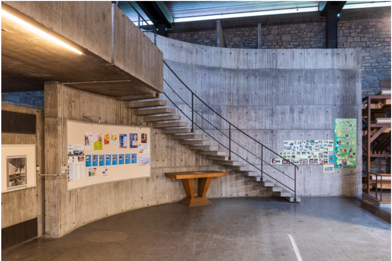
Escalier courbe donnant accès à la tribune sud. Vue de côté.
