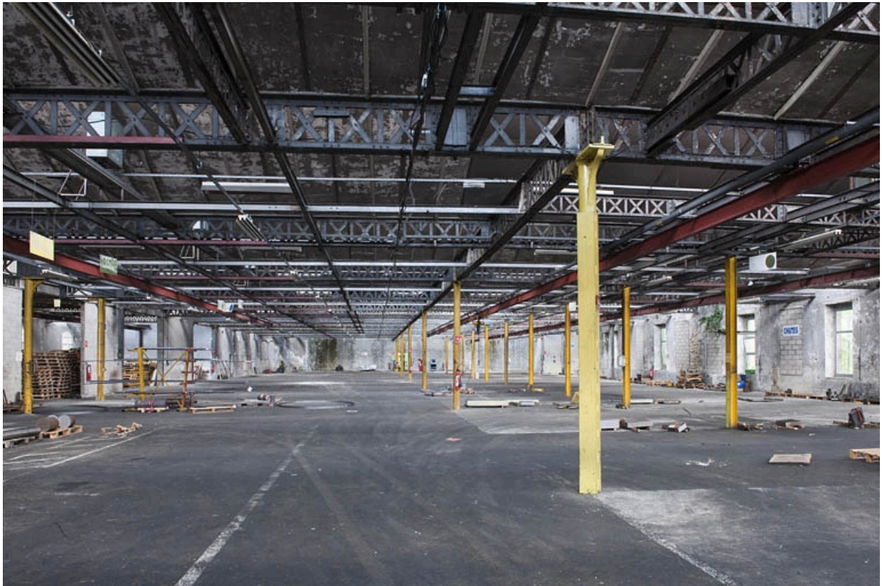
Atelier de fabrication. Vue depuis le nord.
