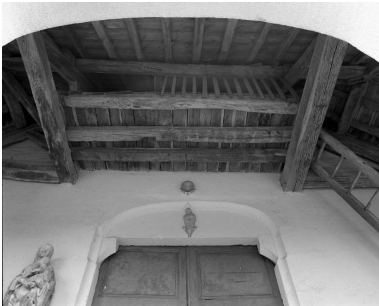
Porche, galerie permettant l'accès au clocher.
