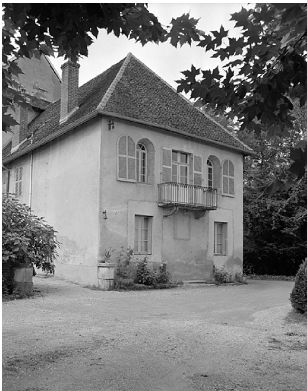
Façade antérieure du bâtiment A.
