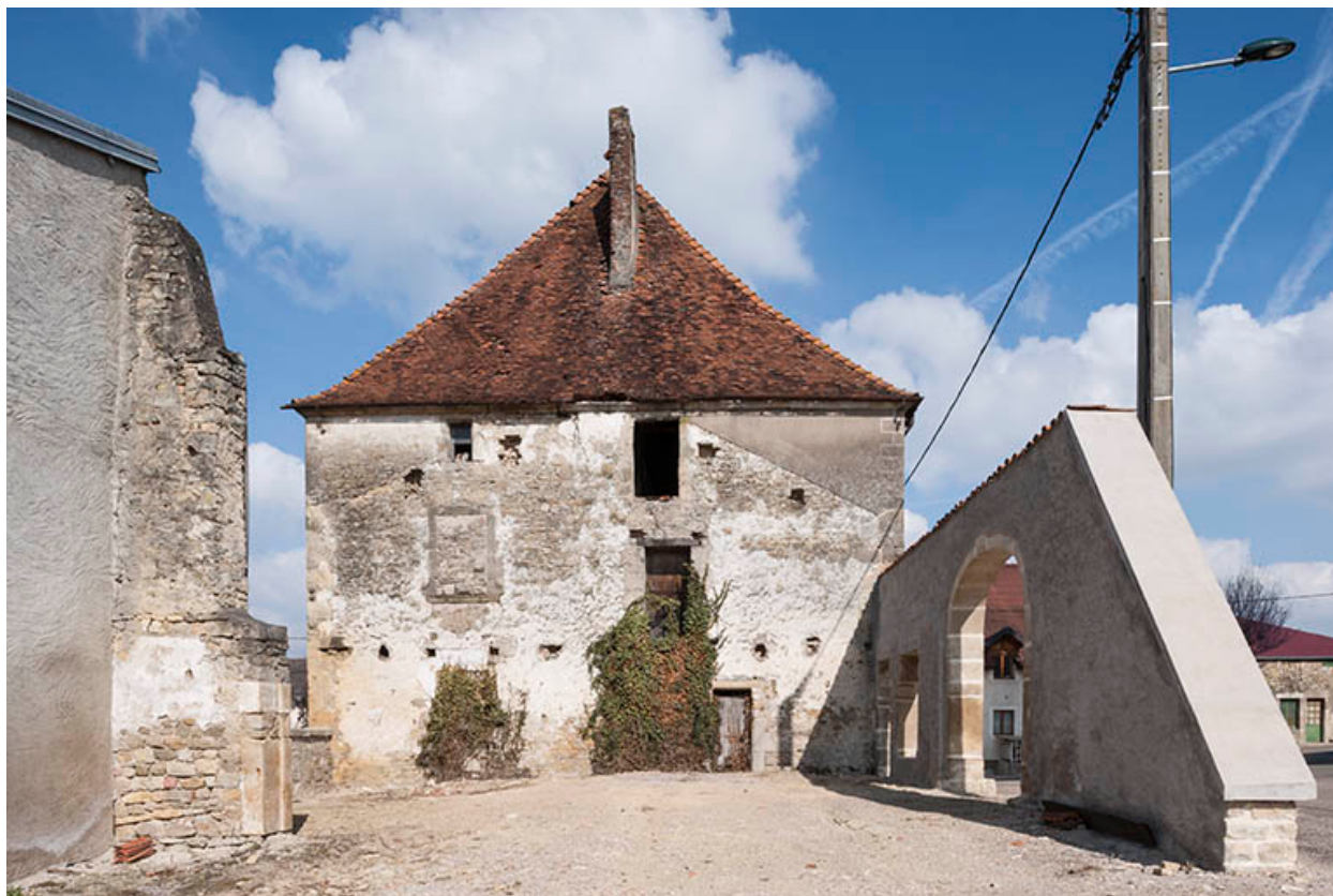
Mur pignon sud.
