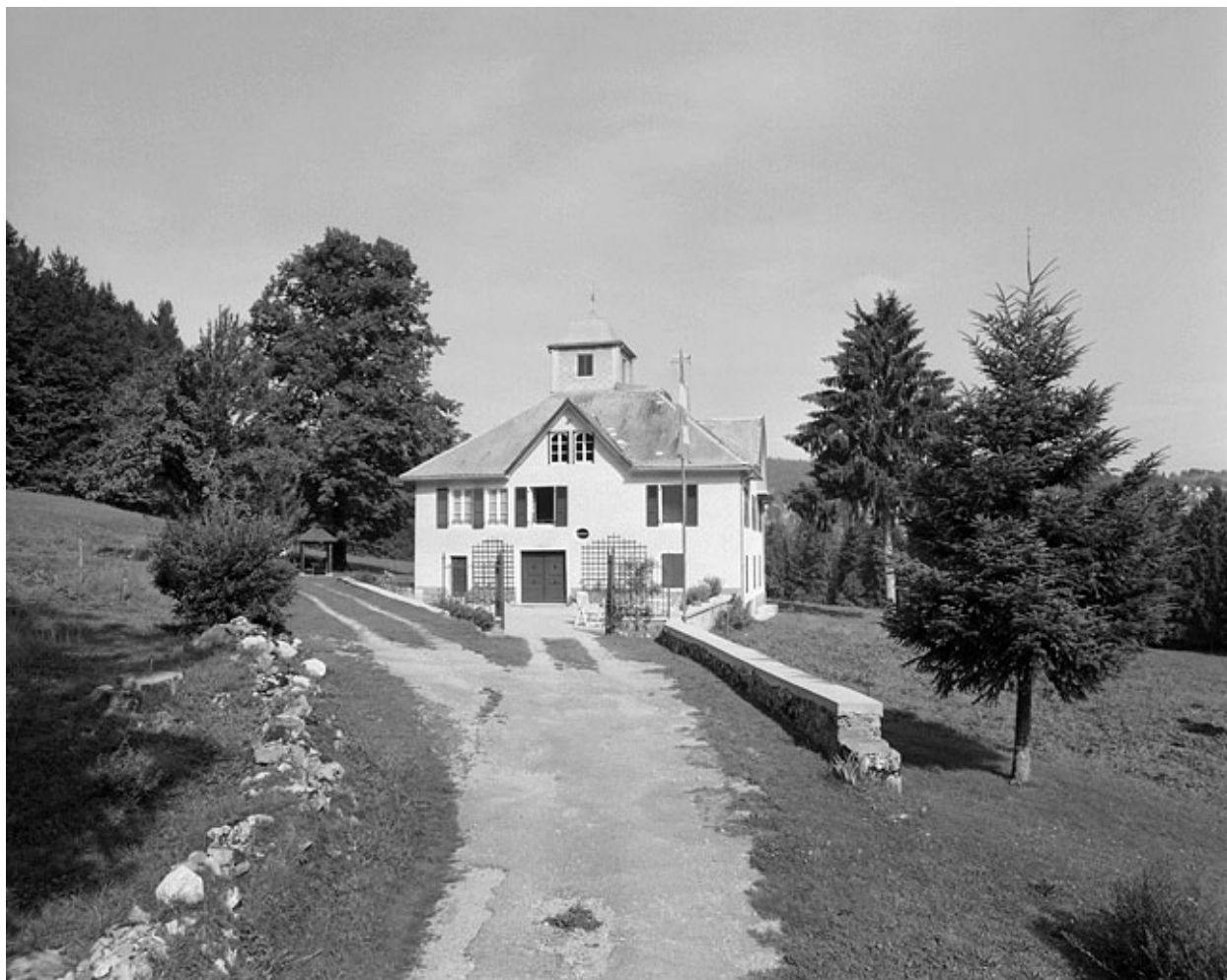
Façade antérieure, vue éloignée.
