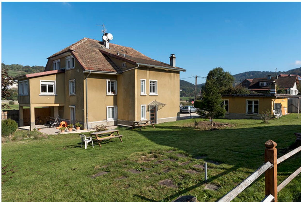
Façades postérieure et latérale droite.
