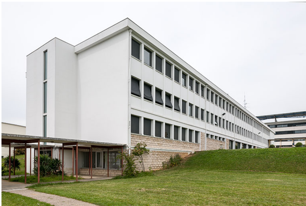
Externat : ancien bâtiment, pignon sud.
