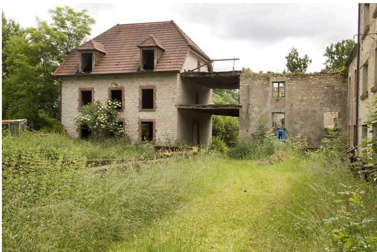
Logement et bâtiment en ruine.
