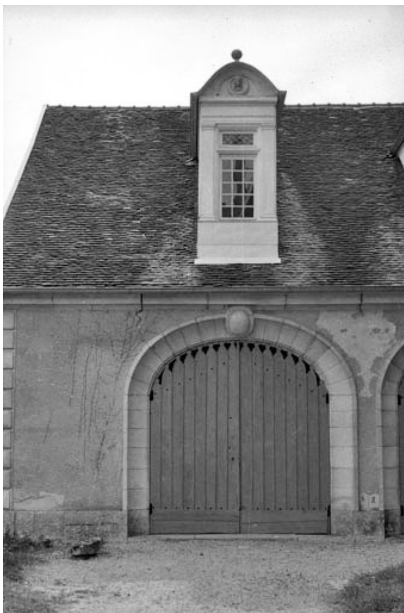
Les remises : détail d'une porte.
