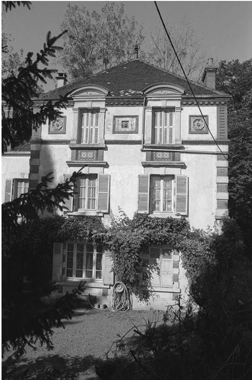
Façade sud du logement patronal.
