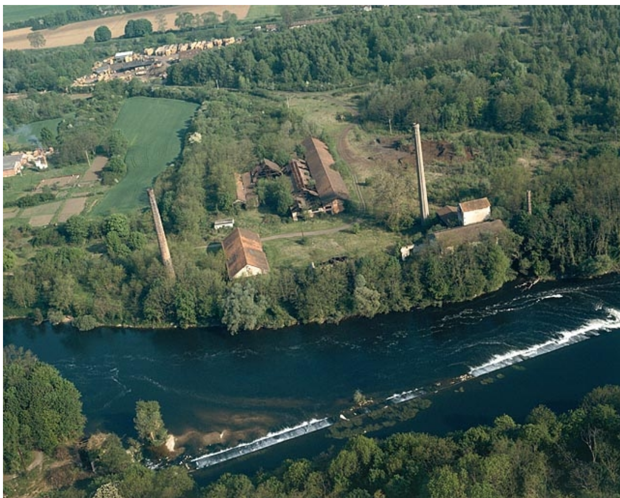
La Forge Neuve vue du sud-est, photographie aérienne.
