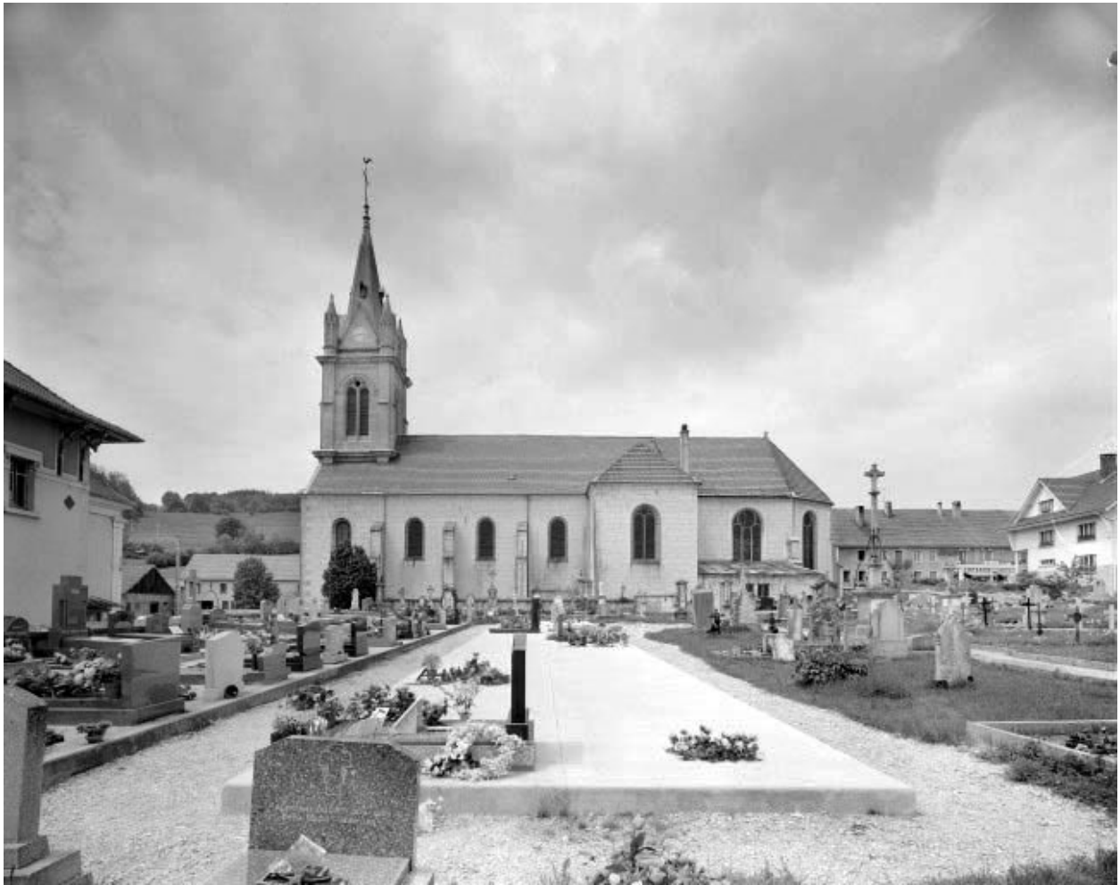
Façade latérale droite.
