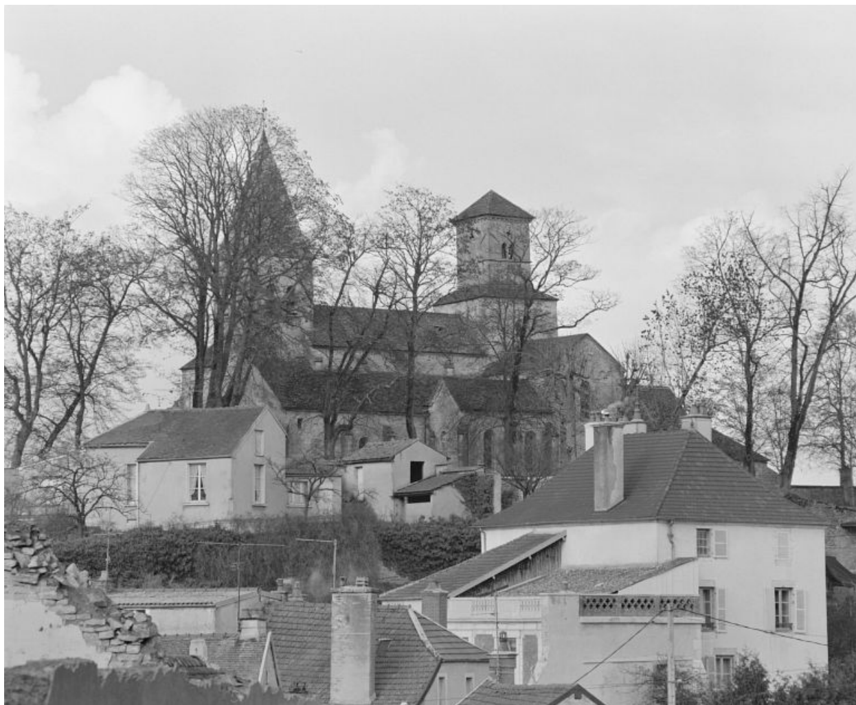
Vue d'ensemble du site, au sud
