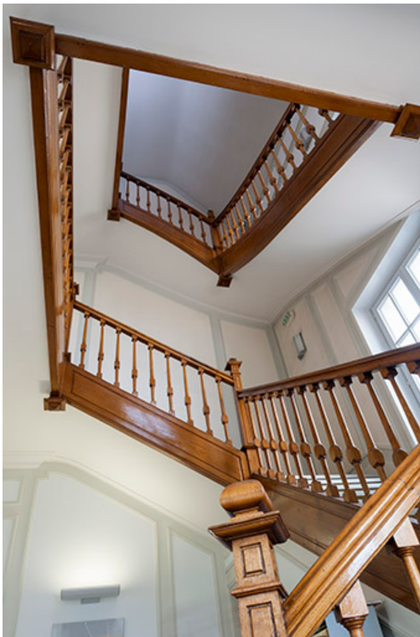
Hall d'entrée : cage d'escalier, vue en contre-plongée.
