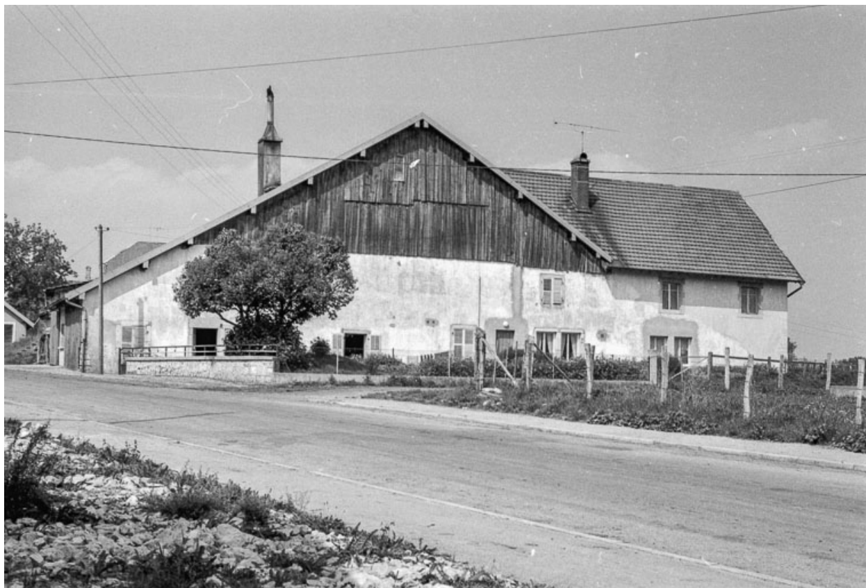
Ferme cadastrée 1973 ZE 31a : façade antérieure.
