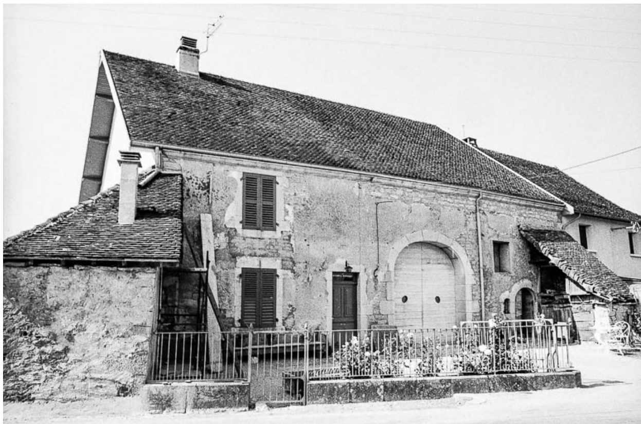
Ferme cadastrée 1960 AH 86 : façade antérieure.
