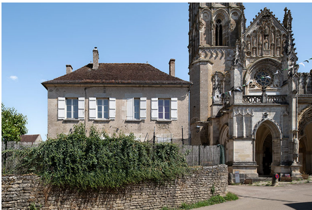
La façade antérieure depuis la rue de l'Abbé-Pissier.
