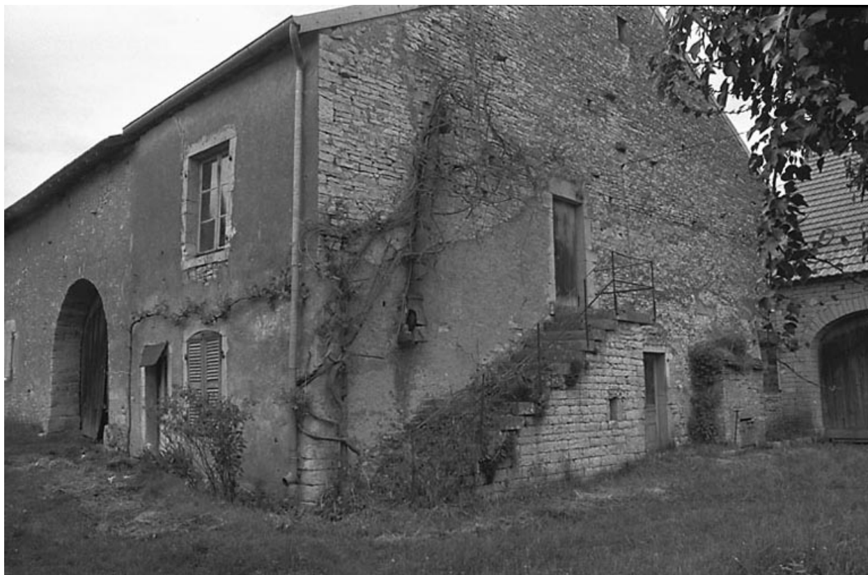
Vue de l'habitation.
