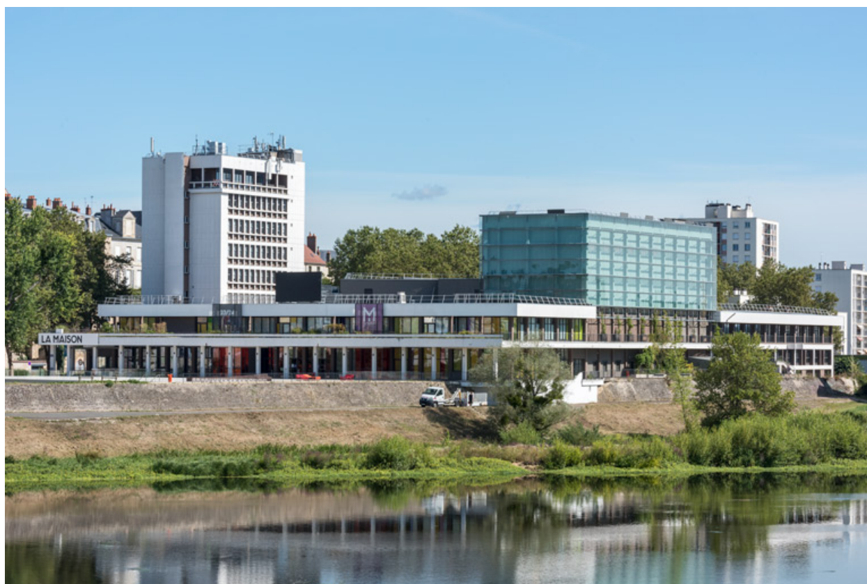
Façades postérieure et latérale droite.
