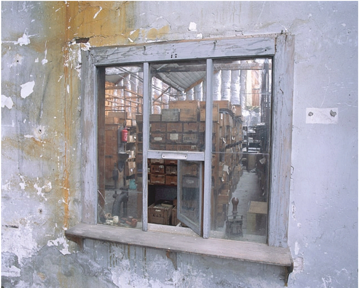
Guichet entre le magasin de fournitures et l'atelier de fabrication de pipes.
