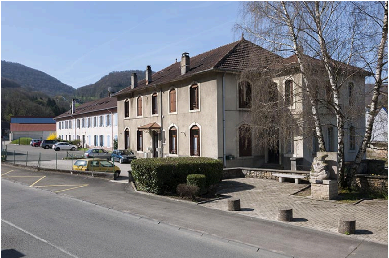
Bâtiments de bureaux (rive droite) depuis le nord-est.
