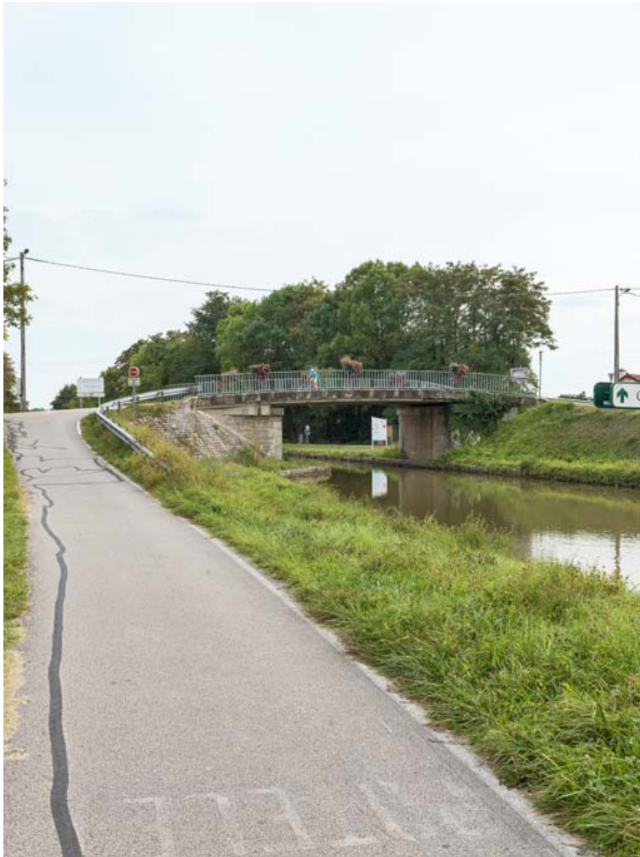
Vue d'ensemble du pont.
