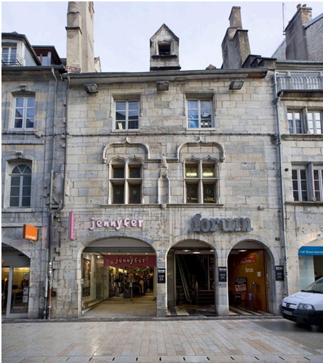
Façade antérieure du 15 Grande Rue : de face.
