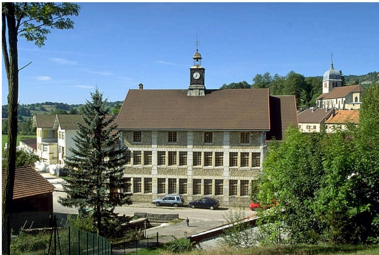
Foncine-le-Haut : usine d'horlogerie Château.
