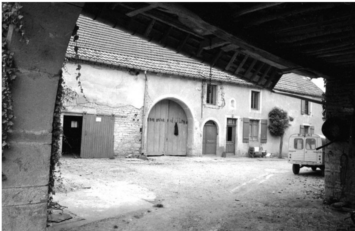
Bâtiment de gauche : façade sur cour.
