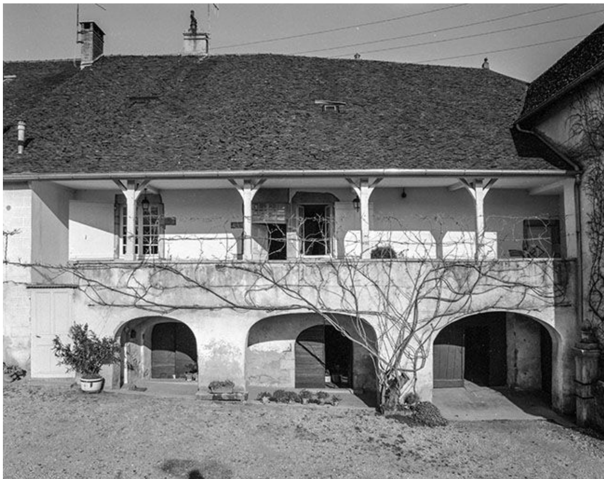
Façade antérieure vue de face.
