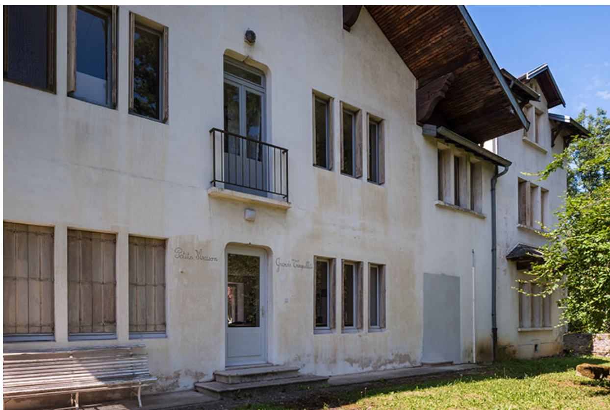
Chalet Colette : façade postérieure.
