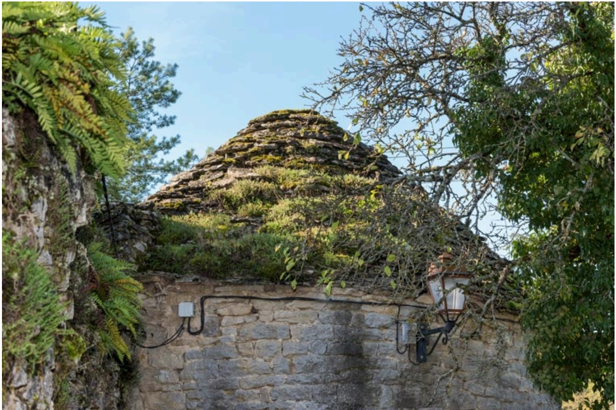
Détail de la toiture de la première tour.
