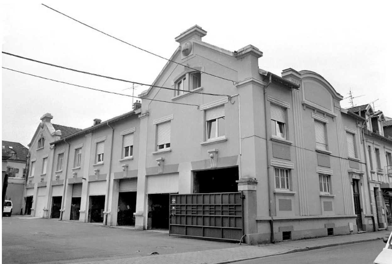
Bâtiment abritant des remises et des logements.
