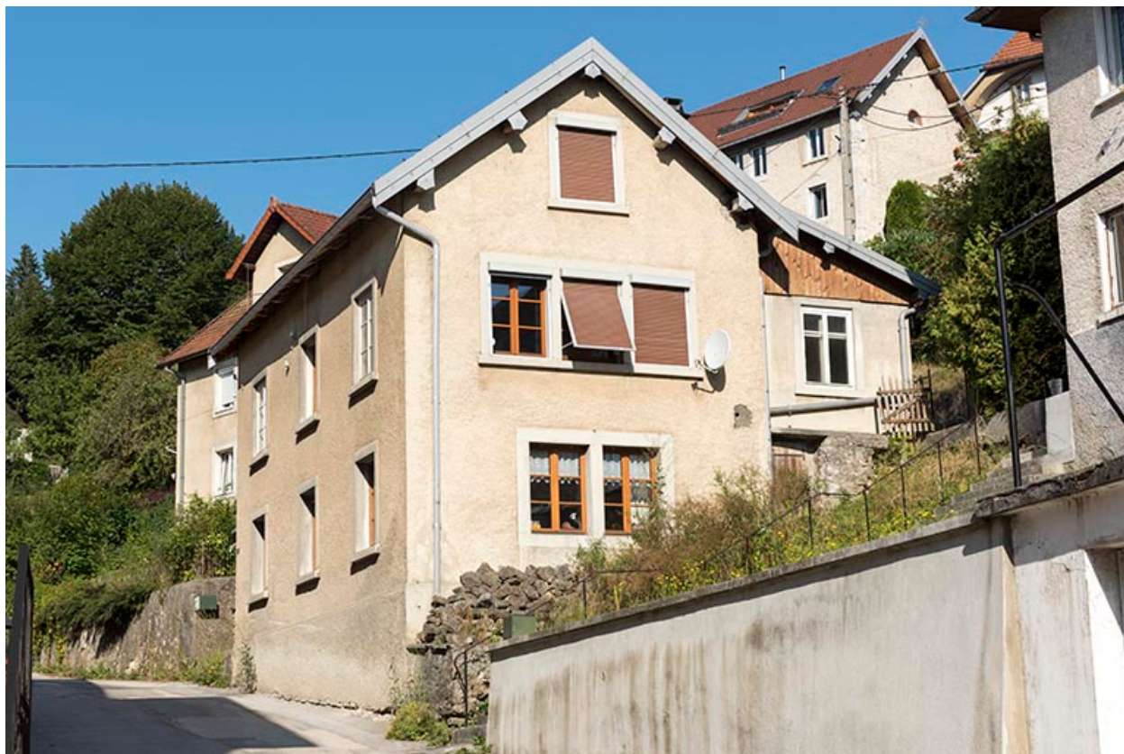
Façades antérieure et latérale droite.
