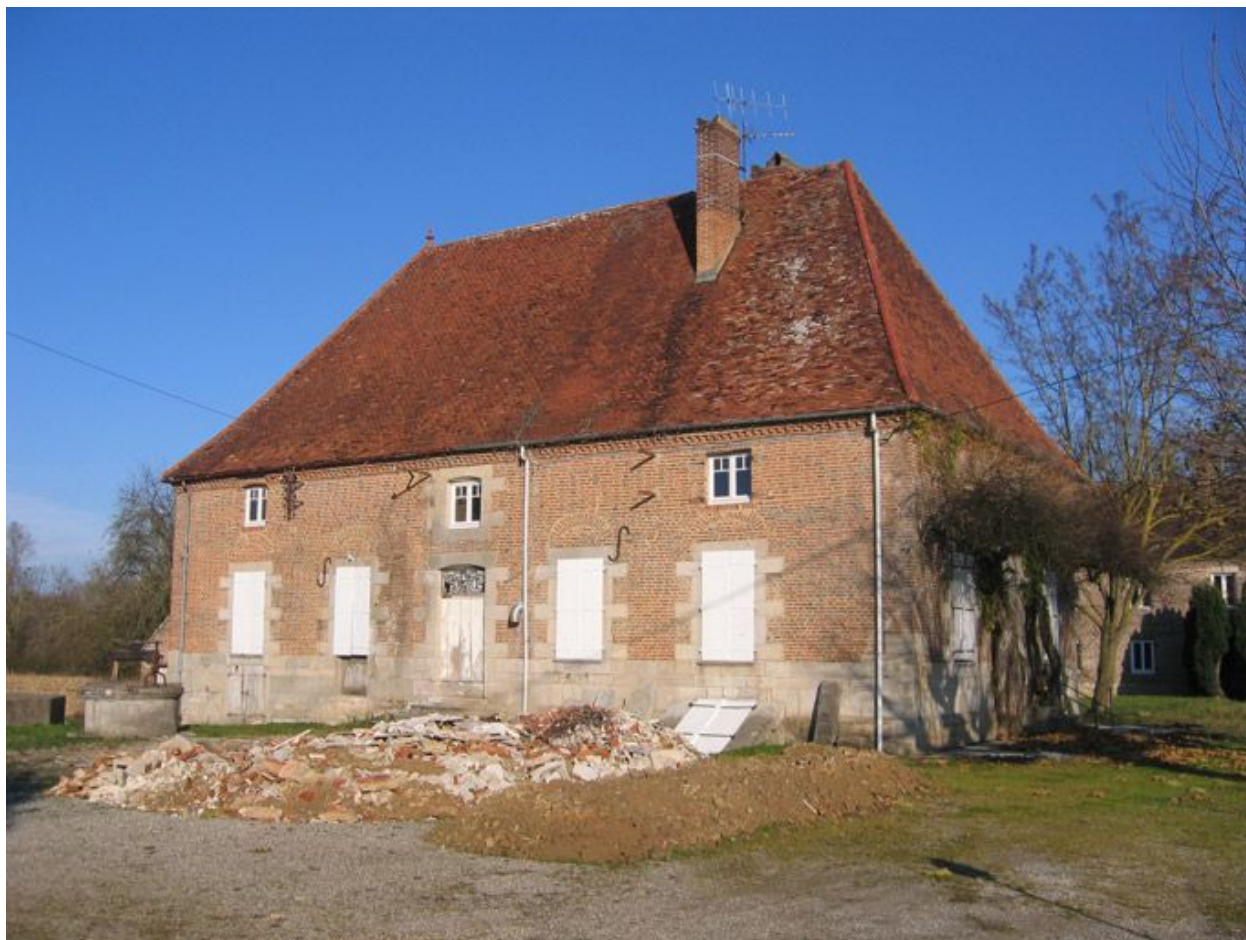
Vue d'ensemble de la façade de l'habitation.
