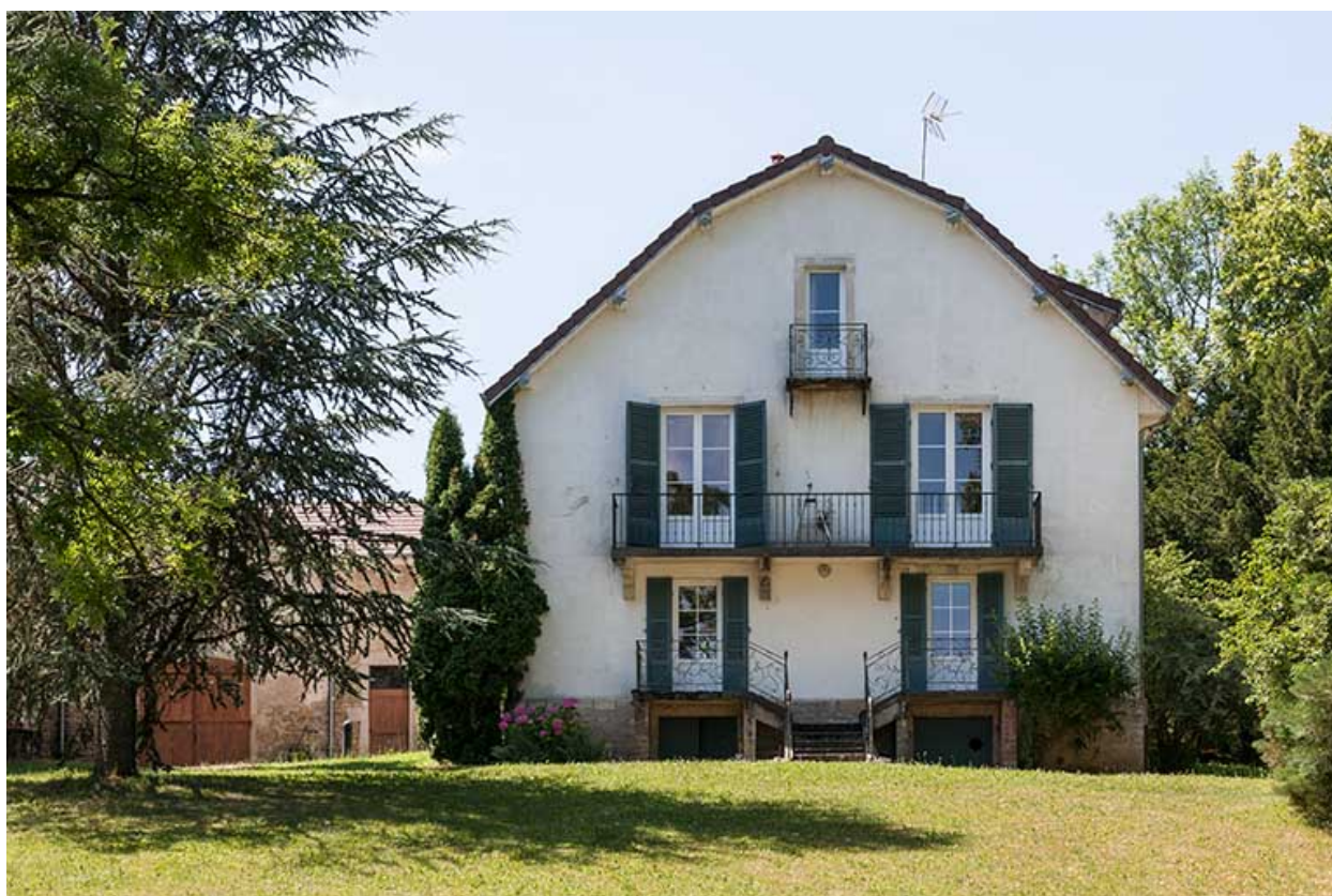
Pavillon du proviseur : façade antérieure.
