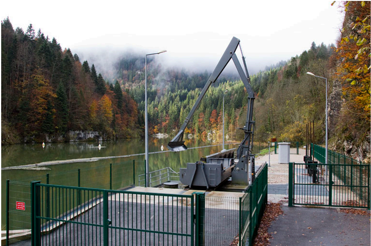
Prise d'eau : vue d'ensemble.
