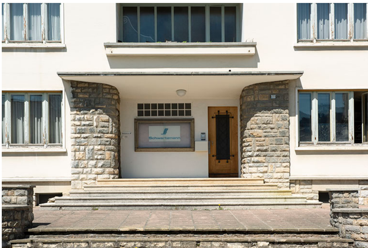
Façade antérieure : entrée.
