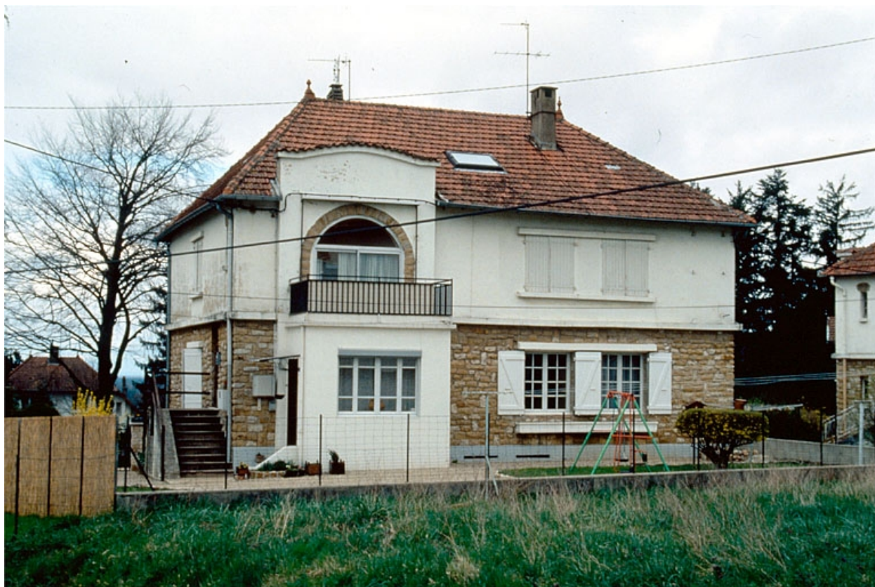
Maison (H) : façade postérieure.
