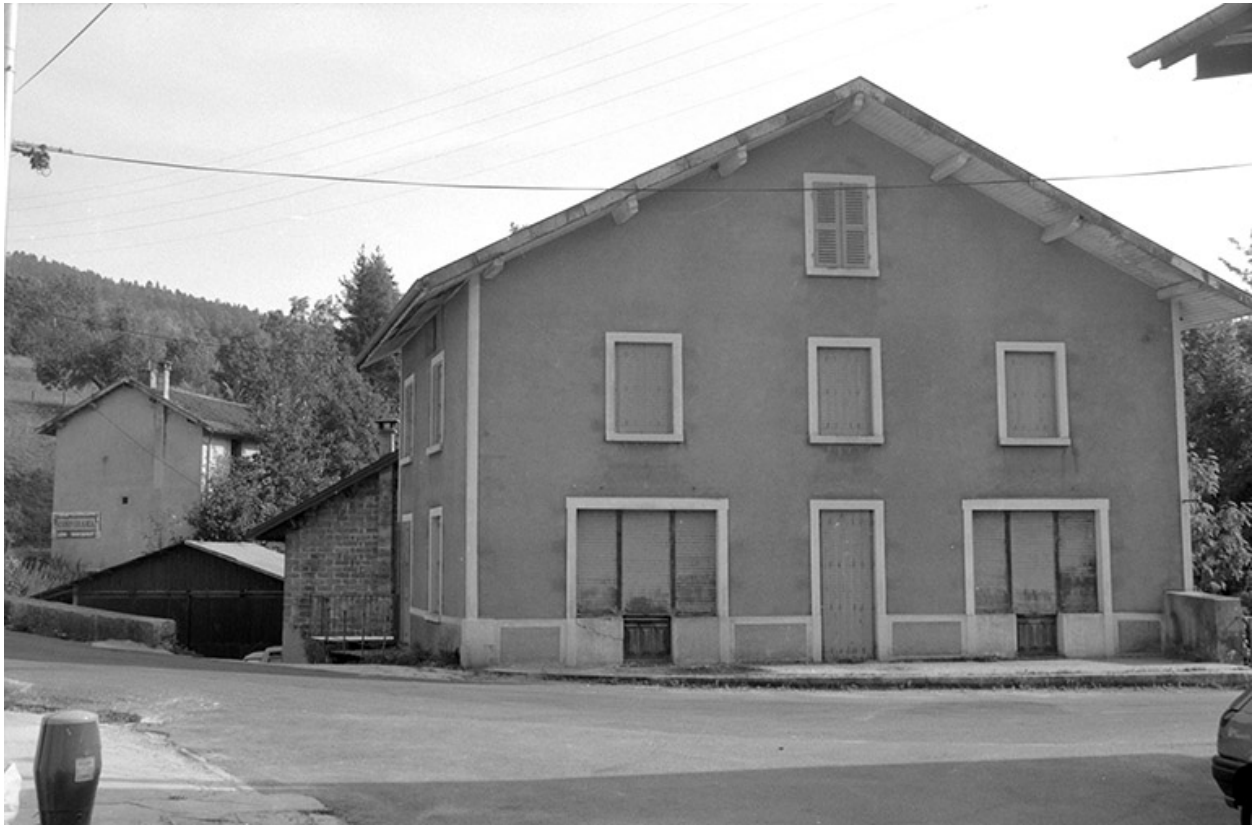
Façade antérieure du logement.
