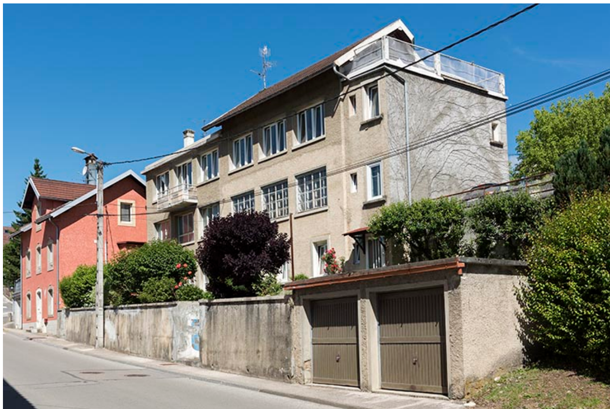
Façades sud et est.
