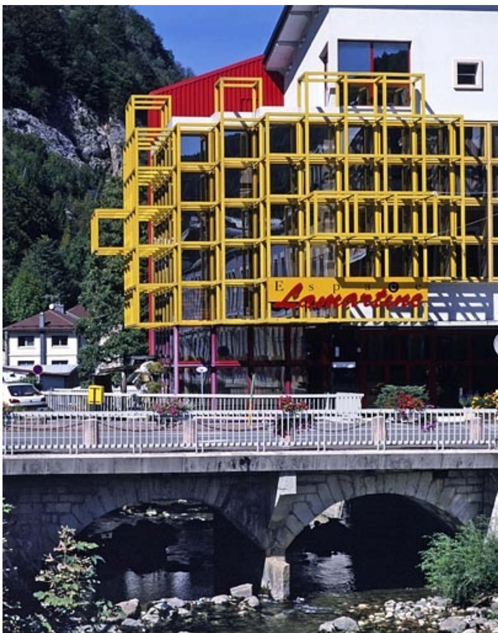
Pont Lamartine, depuis la rive gauche en amont.
