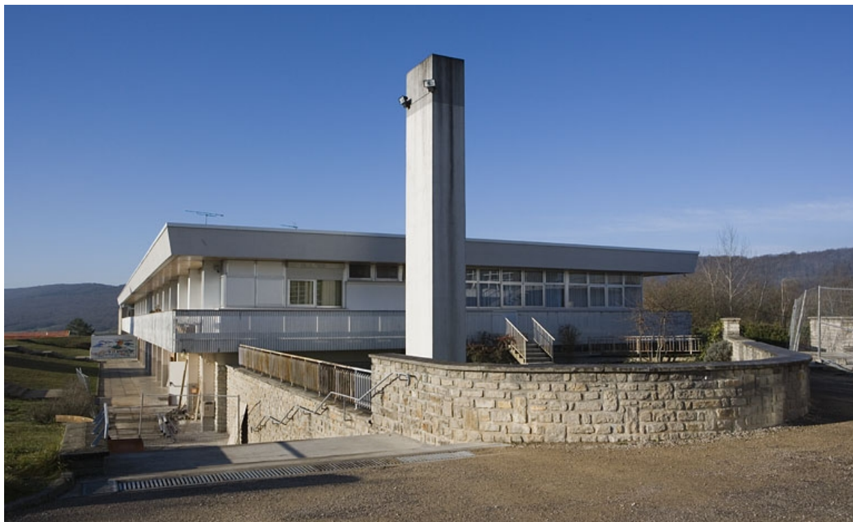
Internat : vue d'un pignon.
