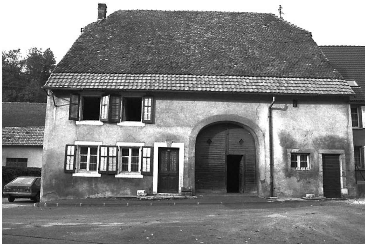
Ferme située rue du Château d'Eau.
