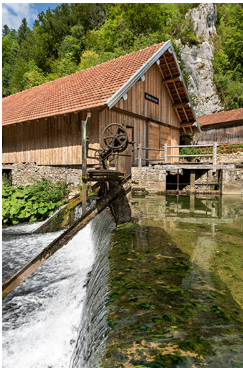
Barrage et vannes, depuis la rive gauche.
