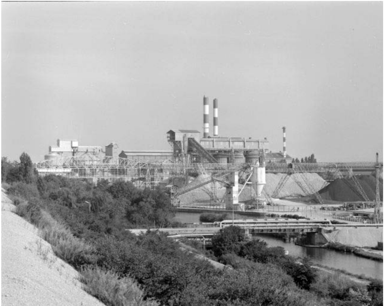
Caisses à soude (13) et fours à chaux (9) vus du haut des bassins de décantation.
