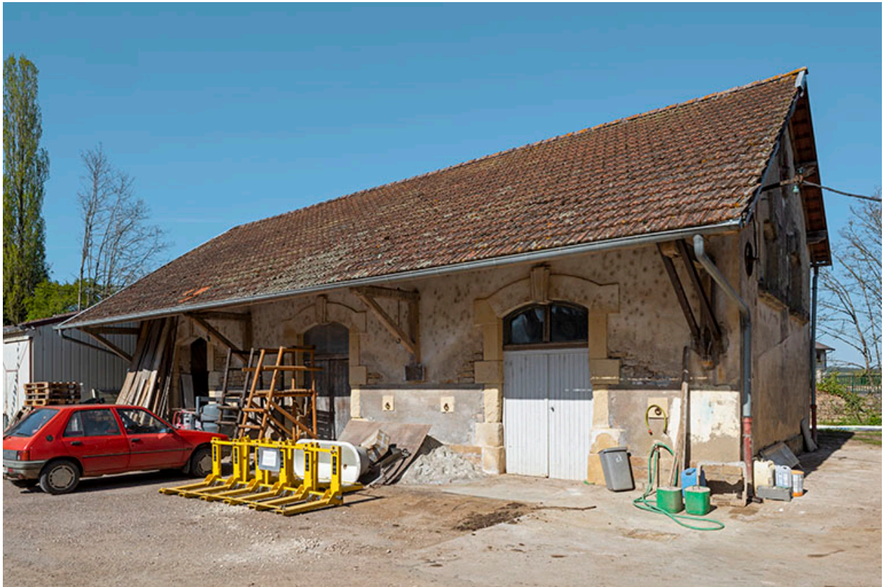
Le bâtiment central, de face.
