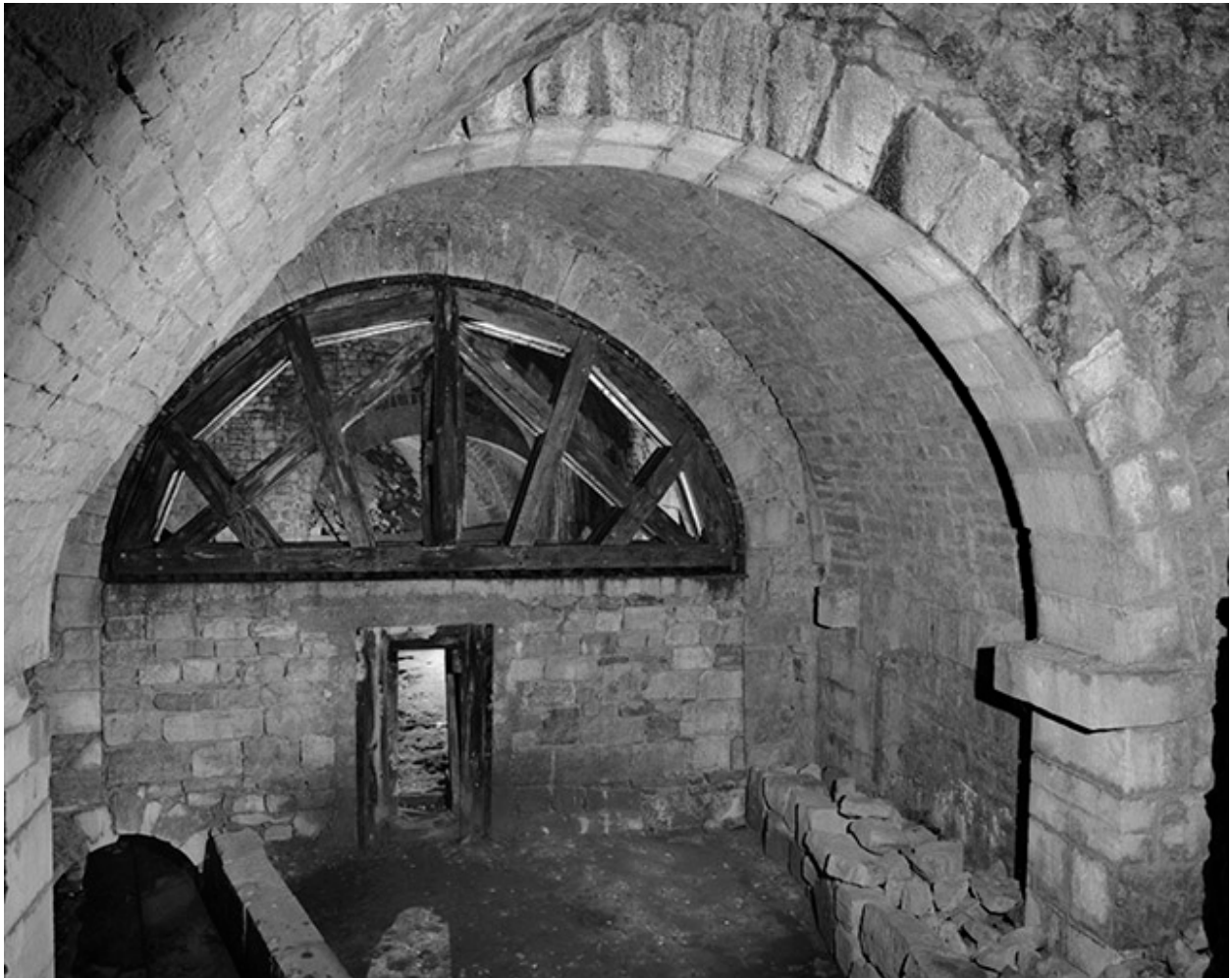
Puits d'Aval ou à Grès : cintre de soutènement (1993).
