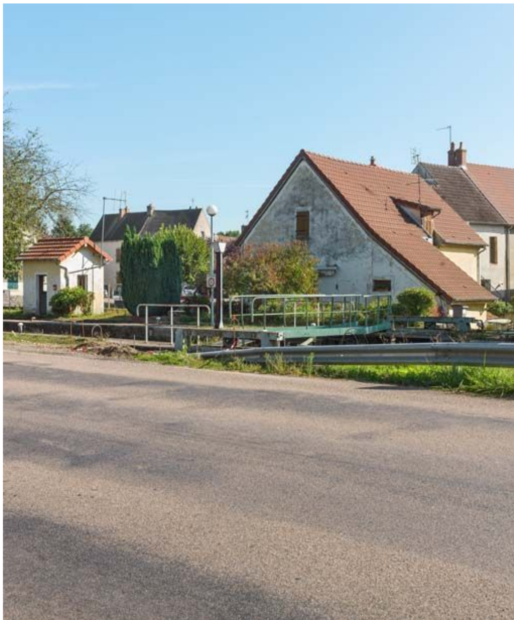
Vue rapprochée de l'écluse.
