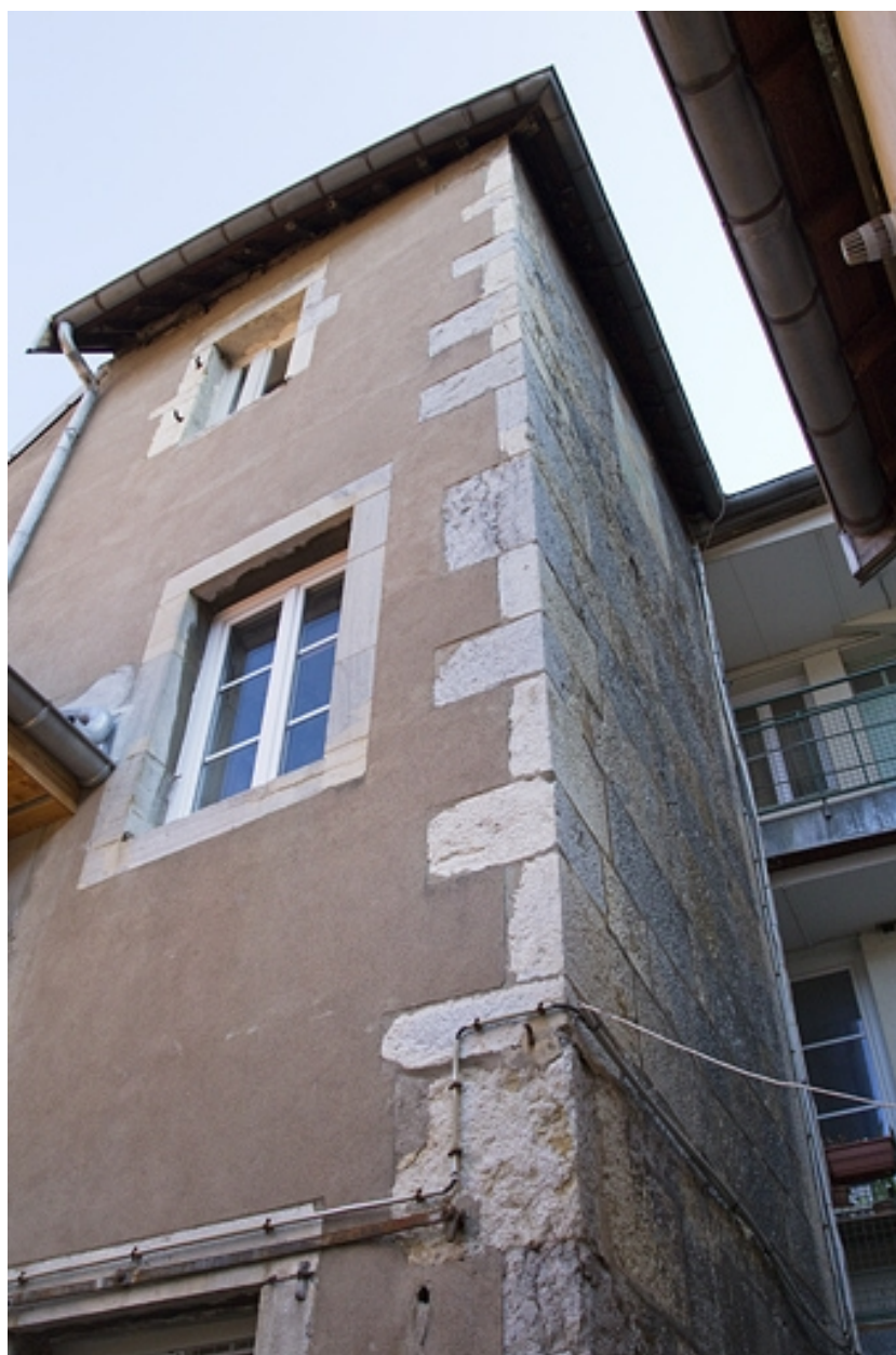
Logis principal : détail de l'aile sur cour.
