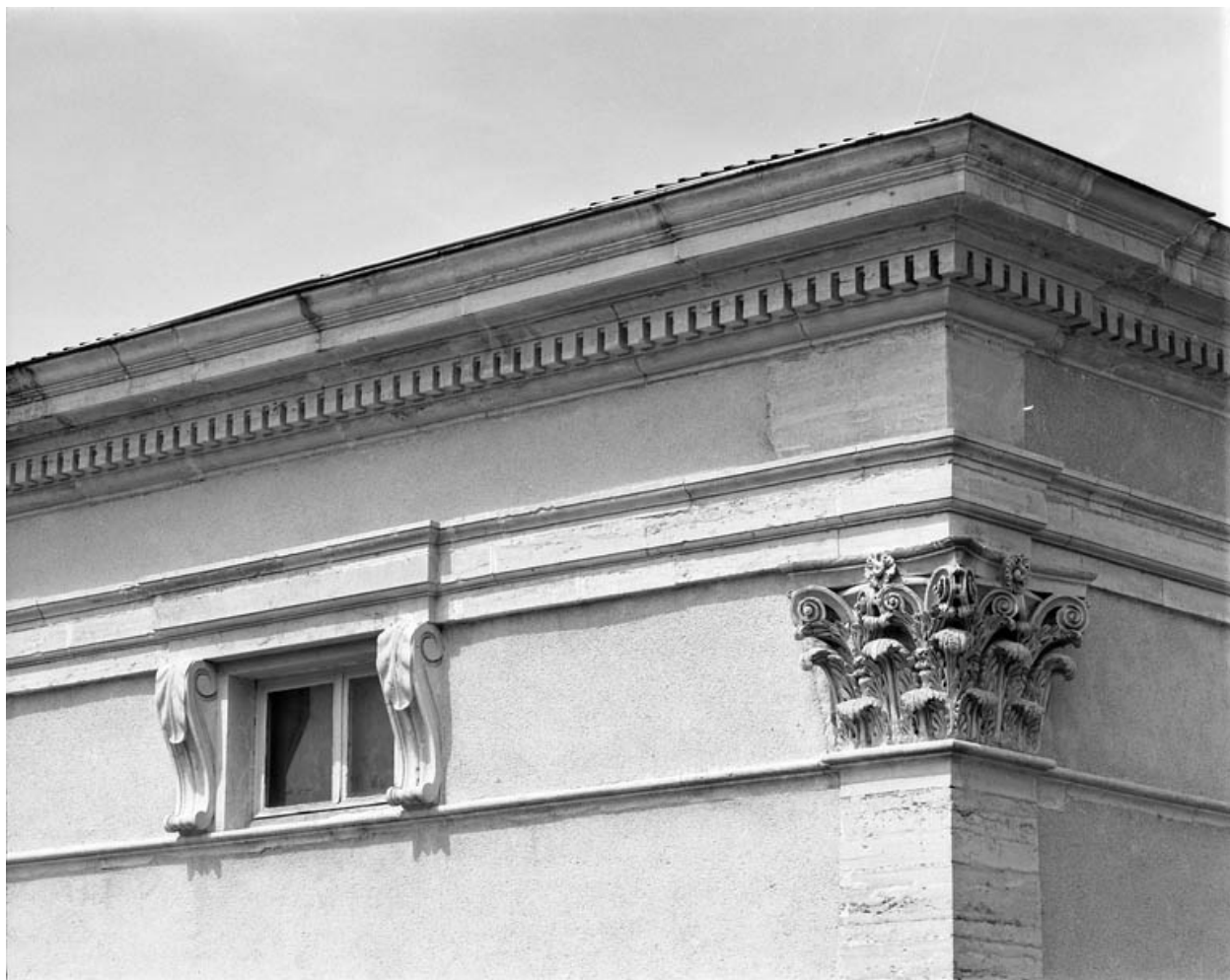
Façade antérieure : détail de l'attique.
